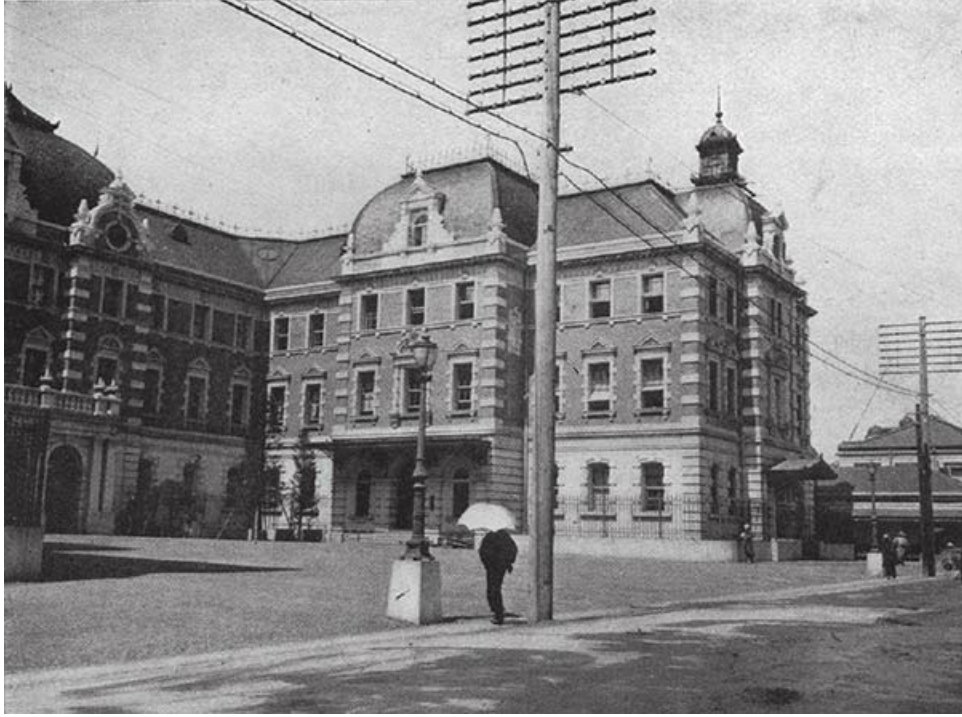
位于东京的日本邮船会社总部
