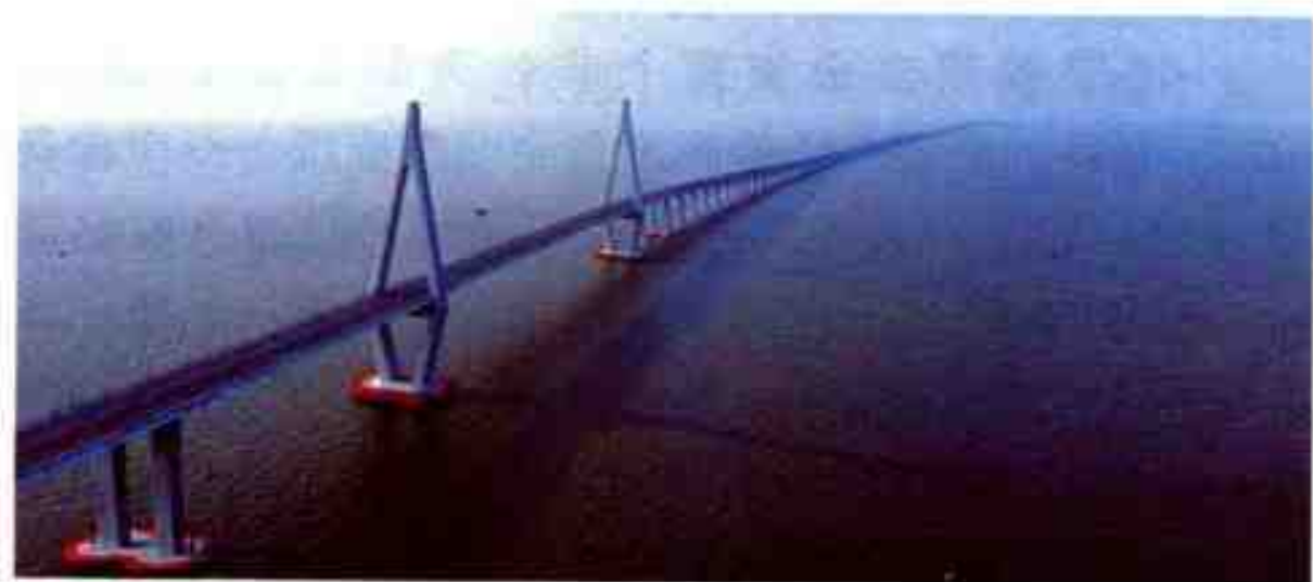
杭州湾跨海大桥
