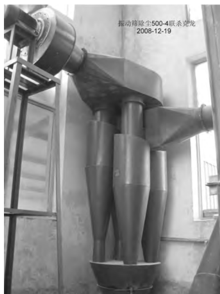
图 5-3 旋风除尘系统
