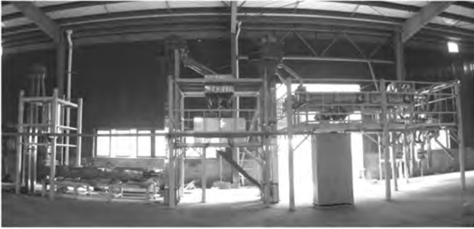
图 7-33 每小时加工 1000 千克苦荞米生产线现场
