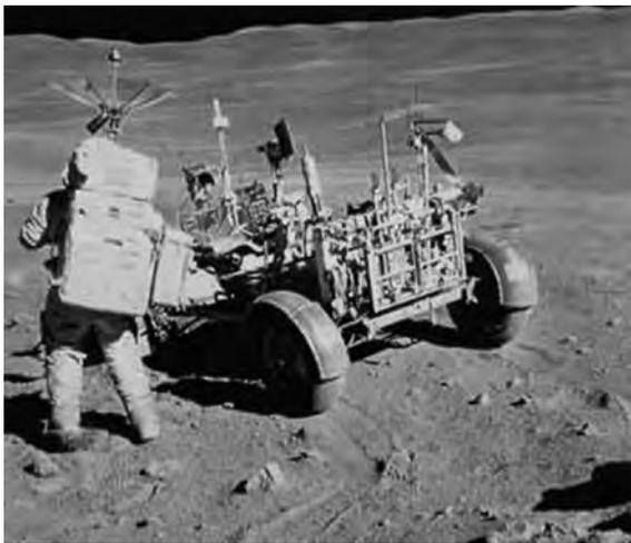
台发动机驱动，靠蓄电池提供动力，轮胎在 $-100^{\circ}\text{C}$ 低温下仍可保持弹性，宇航员操纵手柄驾驶月球车，可向前、向后、转弯和爬坡。
