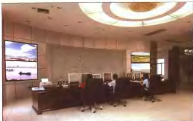
枢纽总控中心
