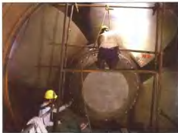
电站机组转轮维修
