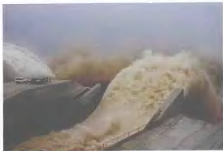
黄河调水调沙小浪底水利枢纽开闸放水（姜拥军 摄）
