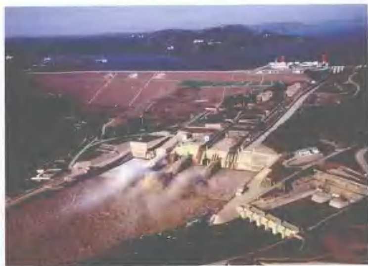
小浪底水利枢纽航拍全貌（梁君 摄）
