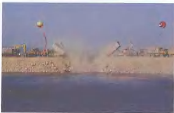
小浪底水利枢纽配套工程——西霞院反调节水库截流现场（姜拥军 摄）
